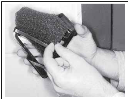
Извлечение фильтра из решетки
